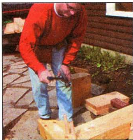
Нагели Ø25 мм забивают в заранее просверленные отверстия, проходящие через соединения паз/шип, и прочно скрепляют балки со стойками.
