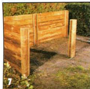
7 В первую очередь между стойками вставляют доски боковых и задней стенок, затем доски перегородки и передней стенки.
