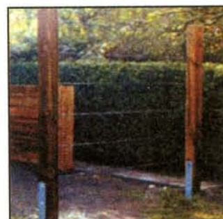
Так выглядит шпалера из двух стоек и стальных прутков, расстояние между которыми - ~30 см.
