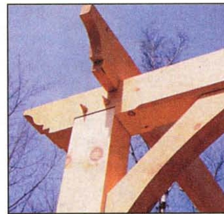
Выпилив пазы в стропилах, крепят их к балкам 12-мм шурупами. Жёсткость конструкции обеспечивается подкосами.
