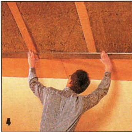
4 Уложив следующую панель, её тщательно выставляют с помощью рейки. При необходимости панель подправляют лёгкими ударами молотка через прокладку.
